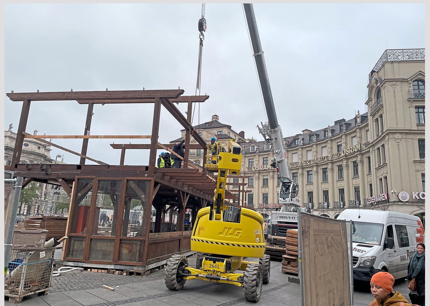
Handwerker werkeln bereits fleißig an der Eislaufbahn und dem Holzbau, in dem es bald Bratwürstl und Glühwein zu kaufen gibt. Foto: rah
